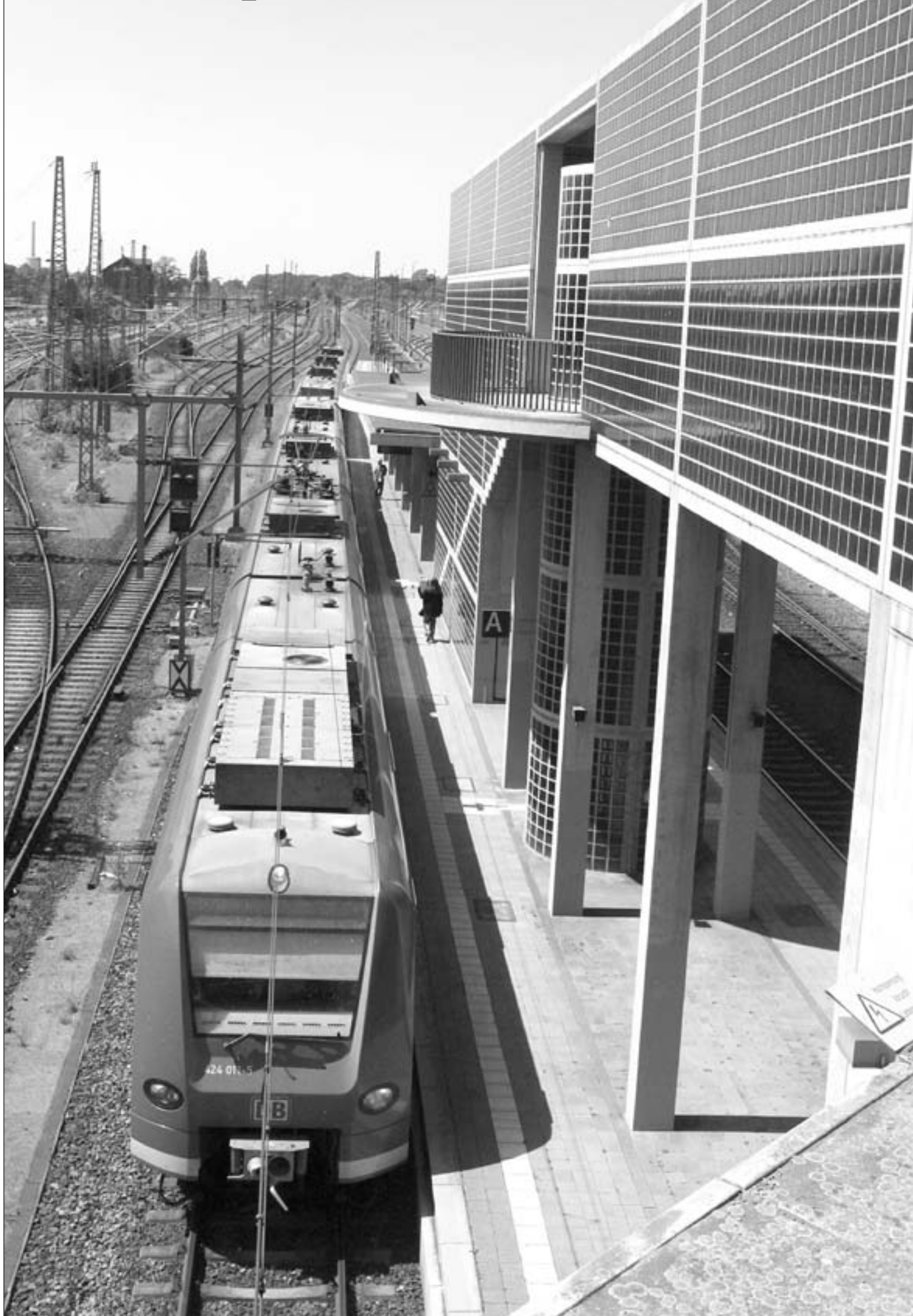
SCHICKE BAHNHÖFE, SCHNELLE BAHNEN: Eine S-Bahn fährt durch den Bahnhof Hannover-Nordstadt.
